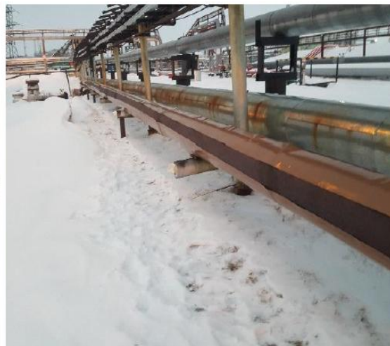
Обогрев трубопроводов пленкой VITEX
